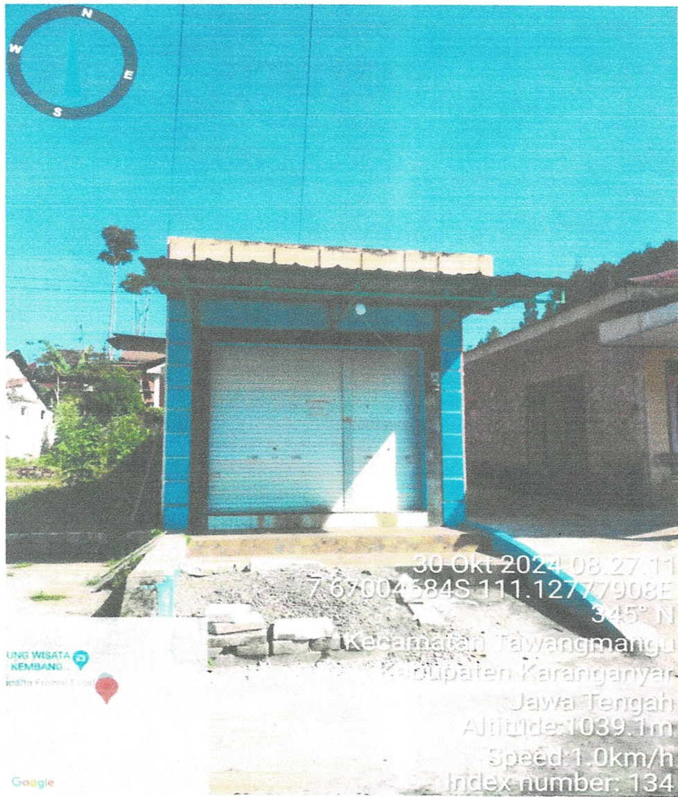
FOTO 0% PEMBANGUNAN GUDANG IVENTARIS NGLURAH RT 05 RW 10 TAWANGMANGU
