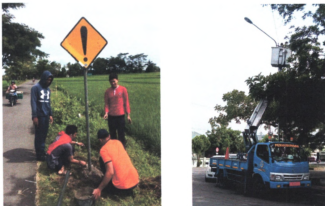
Gambar. 3.1 Perbaikan infrastruktur perhubungan
