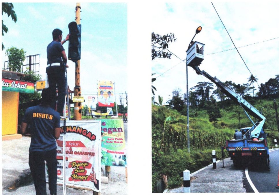
Gambar 3.2 Perbaikan Prasarana Fasilitas LLAJ
