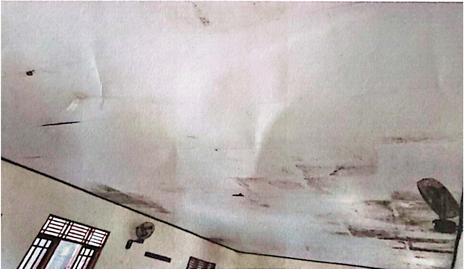
TAMPAK ATAP KANTOR
