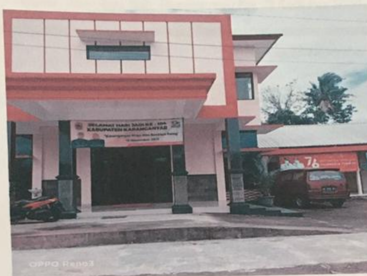
FOTO KOBNDISI BANGUNAN KANTOR DESA SALAM
