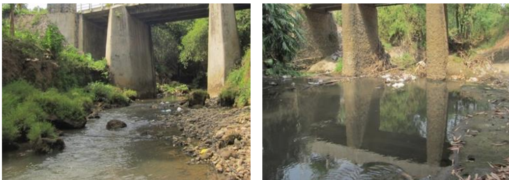
Gambar 62. Dokumentasi kondisi Sungai Sroyo bagian hulu (kiri) dan hilir (kanan)
