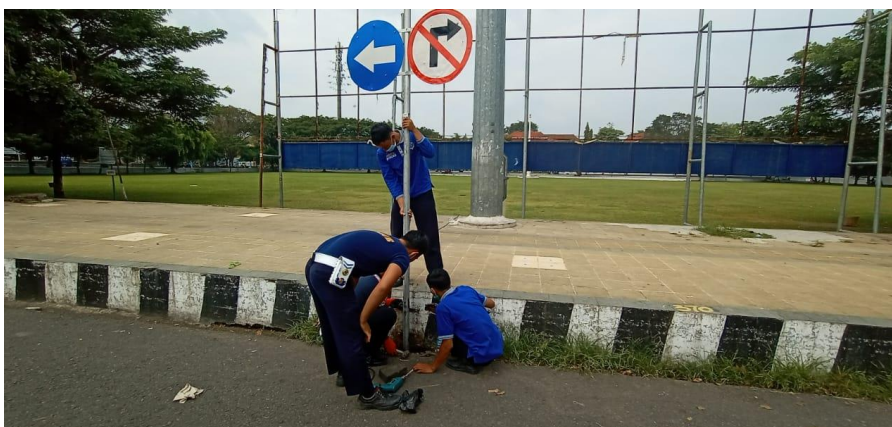
Gambar. 2.1 Perbaikan infrastruktur perhubungan
