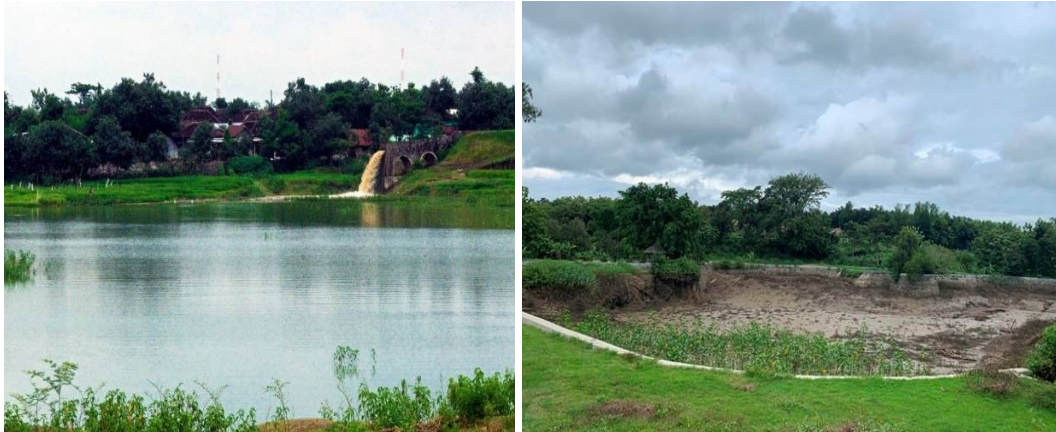
Gambar 58 Waduk Lalung (kiri) dan kondisi Embung Plalar, Kebakkramat yang mengalami sedimentasi parah (kanan, dokumentasi tahun 2020)
